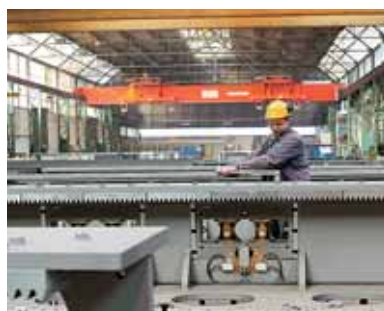
Der Unterbau. In Kassel werden die Bauteile für das Schwebegestell gefertigt.
